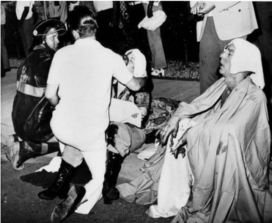
Az UpStairs Lounge ellen 1973-ban elkövetett gyújtogatás áldozatai. Harmincketten haltak meg a támadásban.
