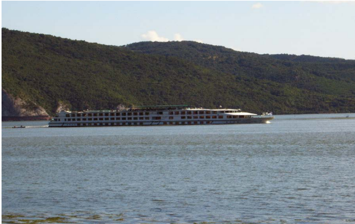
Figure 1. Moldova Nouă overview
