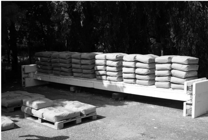
1. ábra: Födém elem terhelési teszt
